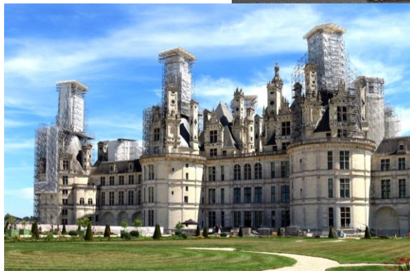
Fațada castelului din Chambord
